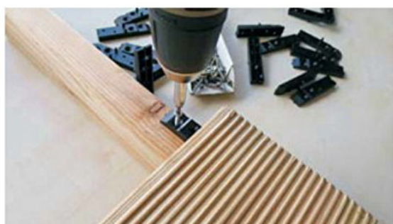
Draai de vlondersplank om en schroef een van de twee terrasplankverbinders op de onderconstructie
