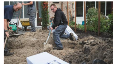
Benodigde diepte en breedte uitgraven
