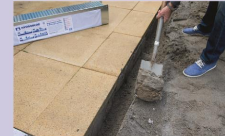
Benodigde diepte en breedte uitgraven
