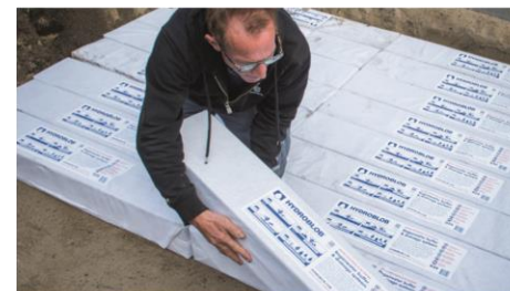
Plaats het gewenste aantal blokken afhankelijk van de oppervlakte en grondsoort
