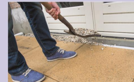
Of Hydroblob® blokken zonder rooster plaatsen en afwerken met grind.
