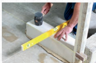
Eerste blok waterpas plaatsen
