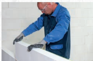
Plaats de volgende steen er tegen
