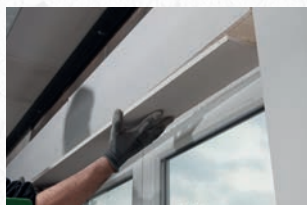
6. Bovenstuk van dagkant plaatsen
