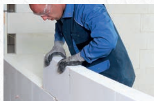
Plaats de steen in de lijmlaag binnen 9 minuten.
