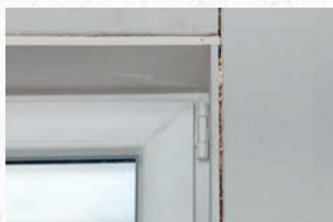
11. Soudal Bouwlijm voor een perfecte afwerking boven.
