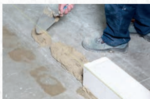
Werk langs een metselkoord
