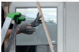
8. Steunbalk plaatsen en zijkant 2
